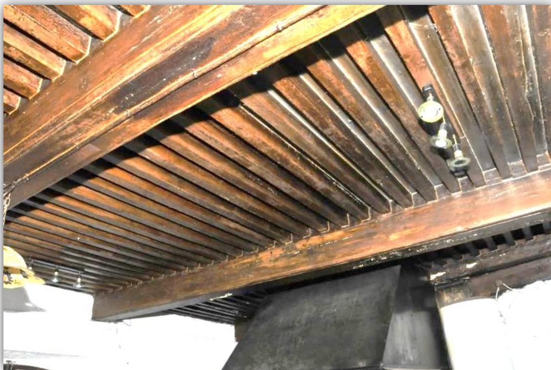
Bâtiment Est, ré de chaussée
