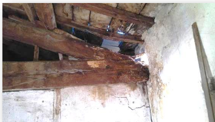
2017 et 2020 (En 3 ans la poutre a lâché le mur et ne repose plus que sur la fragile cloison !)
